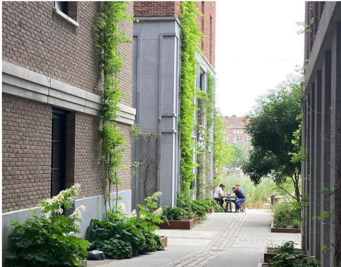
baksteen gevel met kabels voor groen
