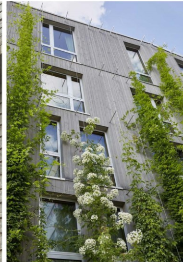
kabels langs houten gevelbeplating
