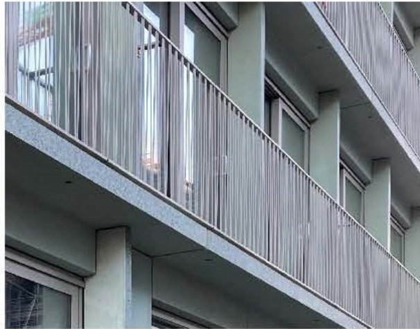
Eenvoudig hekwerk met een eigen karakter
