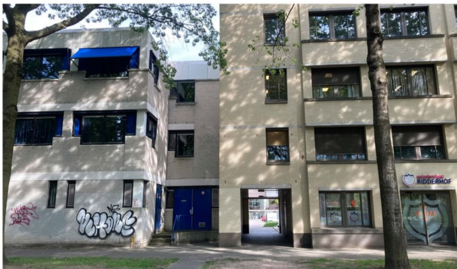
Aansluiting met de buren: poort bij Raadhuislaan 27 (Van Wanrooij-gebouw)
