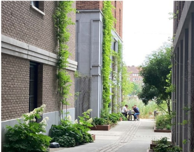
baksteen gevel met kabels voor groen
