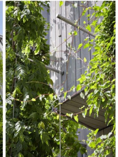
kabels langs houten gevelbeplating
