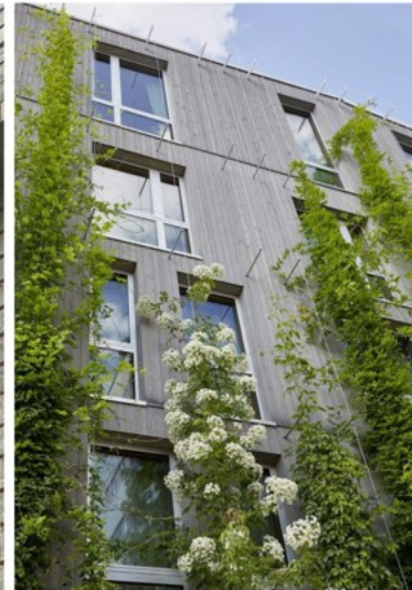
kabels langs houten gevelbeplating
