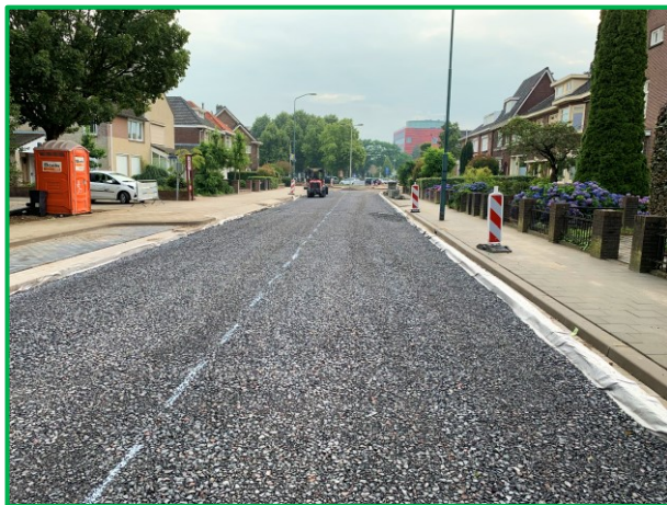
Figuur 6-1: Nieuw wegdek met daaronder nieuwe riolering (foto gemeente Oss)
