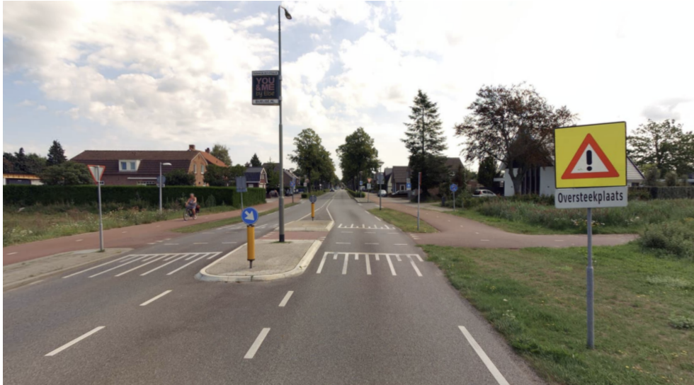
Figuur 4.2: Huidige oversteekvoorziening aan de Osseweg.
