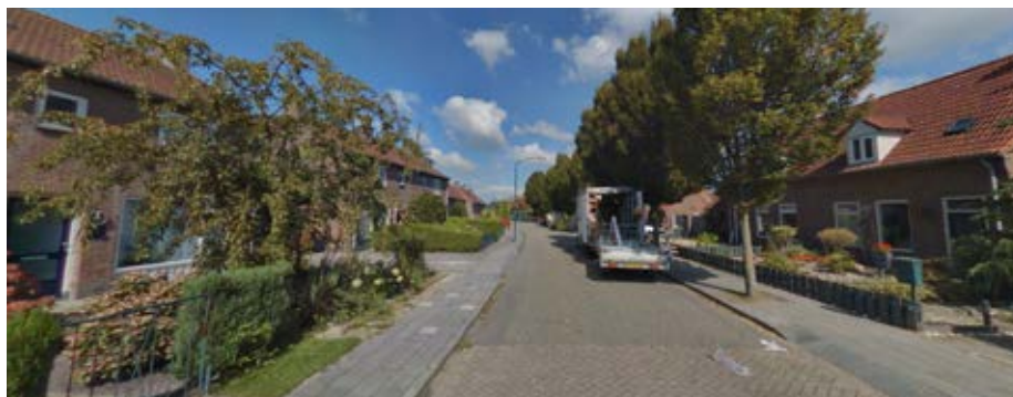
Molenstraat, overgang klinkers en asfalt
