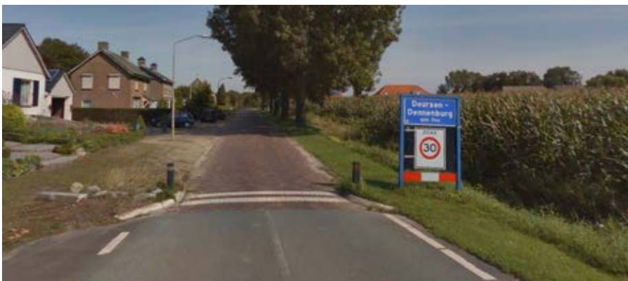
wisseling van materiaal (van asfalt naar klinkers) vindt plaats ter hoogte van het kombord en de dubbele witte streep
