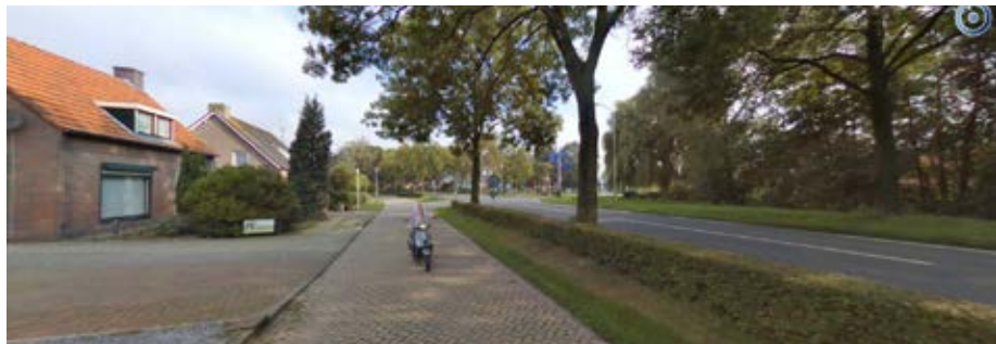
parallelweg in betonklinkers
