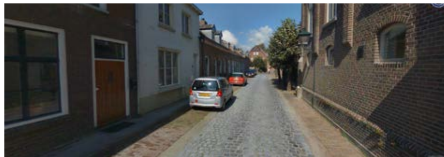
Wilhelminastraat, natuurstenen keien en gebakken klinkers
