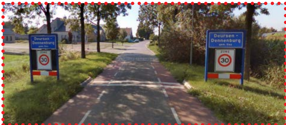
NIET GEWENST ; verkeersremmer en wisseling van verharding valt niet gelijk met de dorpsentree
