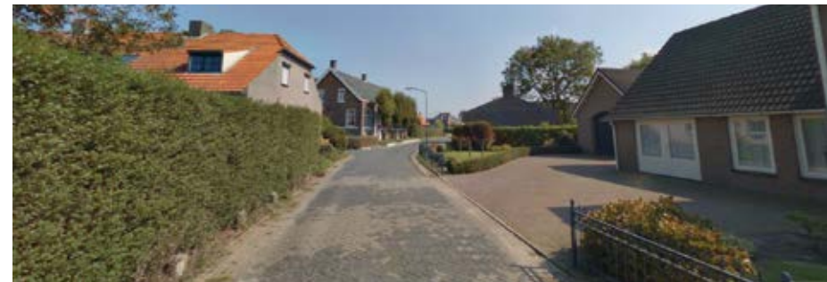
oostelijk deel van de Langwijkstraat, historische weg in klinkers
