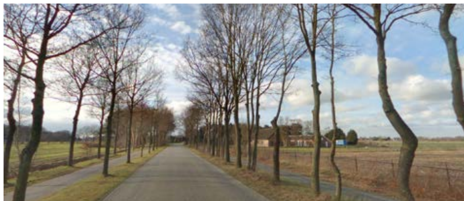
Heesterseweg bestraat met klinkers, uitvoering in asfalt gewenst
