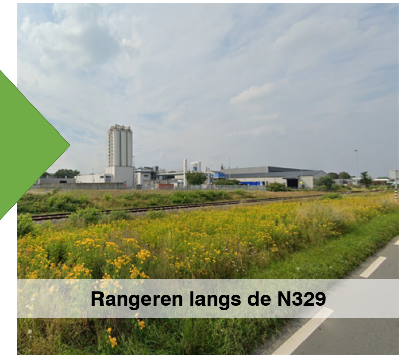
Barrièrewerking tussen noord en zuid
