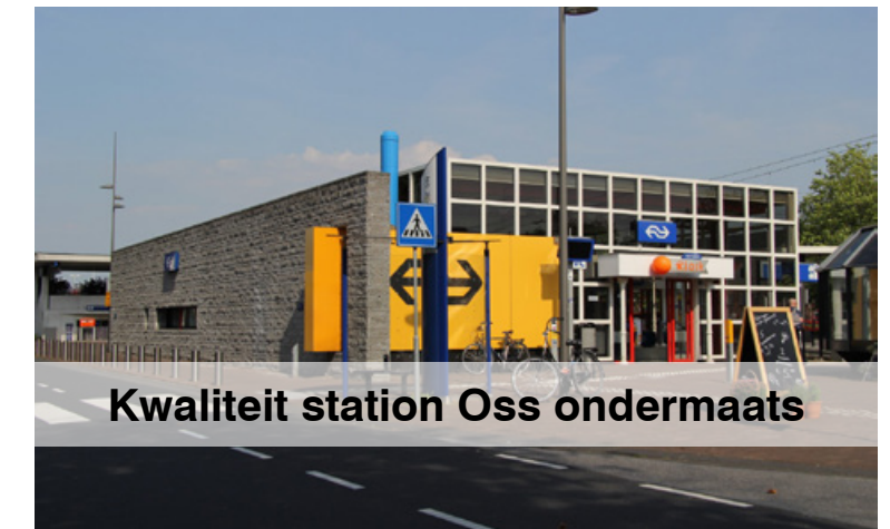
▲ Huidige station Oss aan de Spoorlaan
