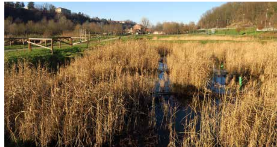
Helofytenfilter voor zuivering van overtollig regenwater
